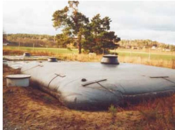
**Figure 15: Réservoir prêt à l'emploi pour le stockage de l'urine à grande échelle à Bornsjön, en Suède.**
