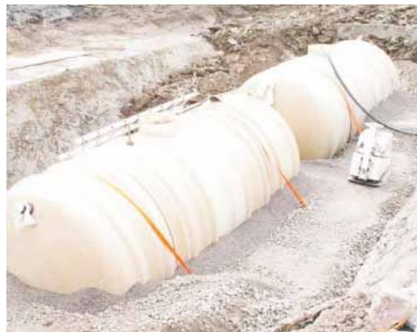
**Figure 17: Réservoir de stockage pendant l'aménagement de la zone d'habitation à Kullön, en Suède. Chaque réservoir est de 12 m<sup>3</sup>.**
