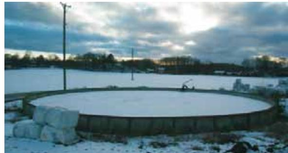
**Figure 16: Réservoir à lisier en hiver, en Suède. Ce réservoir à lisier est réservé à l'urine humaine et il sera équipé d'un couvercle afin de minimiser les pertes d'ammoniac.**
