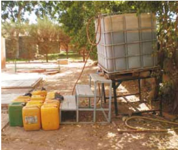
**Figure 13: Stockage de l'urine dans un réservoir d'un mètre cube.**
