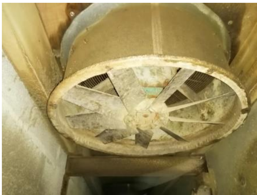
Photo 1 : Les ventilateurs et le couloir technique sont à nettoyer de manière approfondie car la concentration en CIPC y est particulièrement élevée (©M.Martin –ARVALIS)
